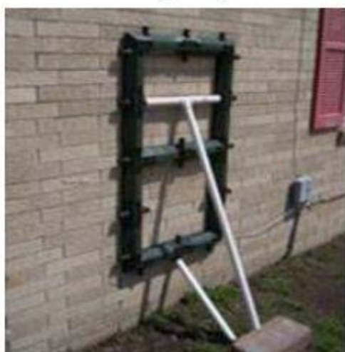
Rys. 39. Wycinanie otworu w ścianie za pomocą pasków detonacyjnych [30].
